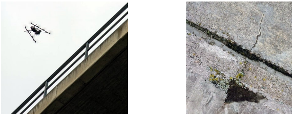
Bild 5. Ein UAV ( Unmanned Aerial Vehicle ) inspiziert eine Brücke (links), Luftbild eines Risses im Beton (rechts) (Bauhaus-Universität Weimar, [8])
